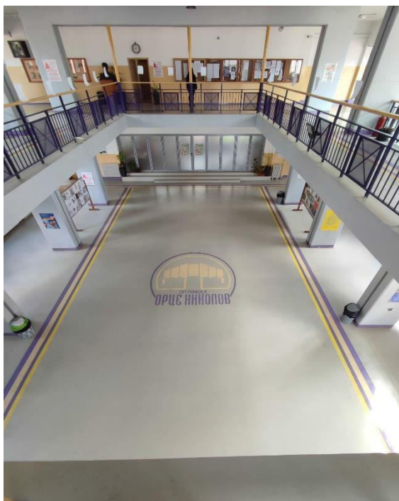
Холот на училиштето со под од епоксиден систем
